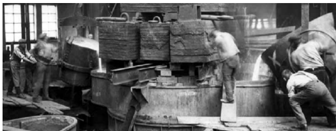
Die Gießerei kämpft sich durch wirtschaftlich schwere Zeiten in den 20er und 30er Jahren. Links: Gießen eines Glättzylinders
